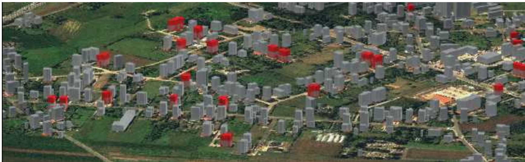
Analiza 3D - Weryfikacja bazy EGIB w zakresie zgodności liczby kondygnacji. Miasto Gliwice. Źródło: WorldView-2, 2011 r.
